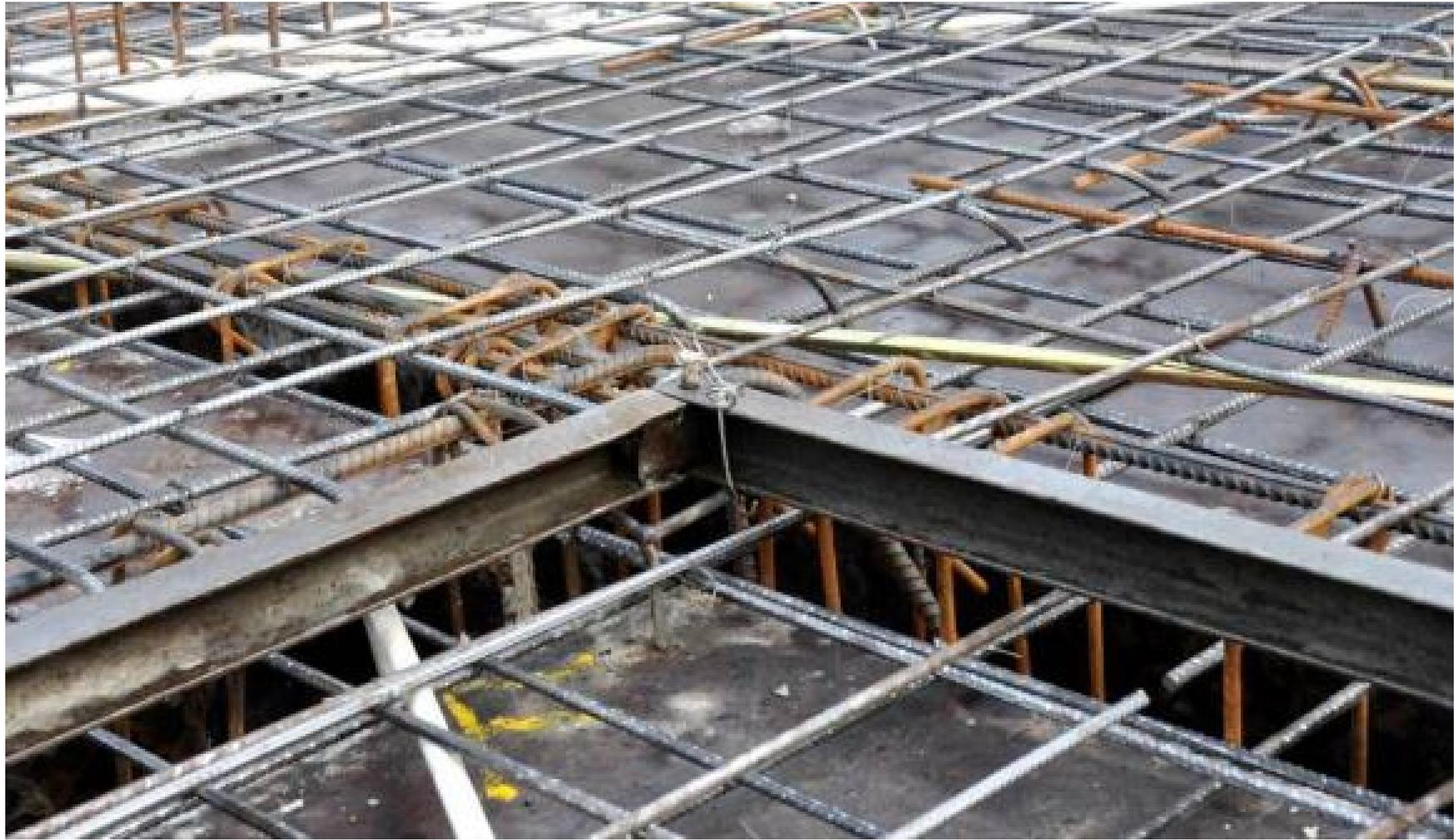
楼面高差控制（定型化做法）采用型钢制作，每次使用前进行清理并刷脱模剂
