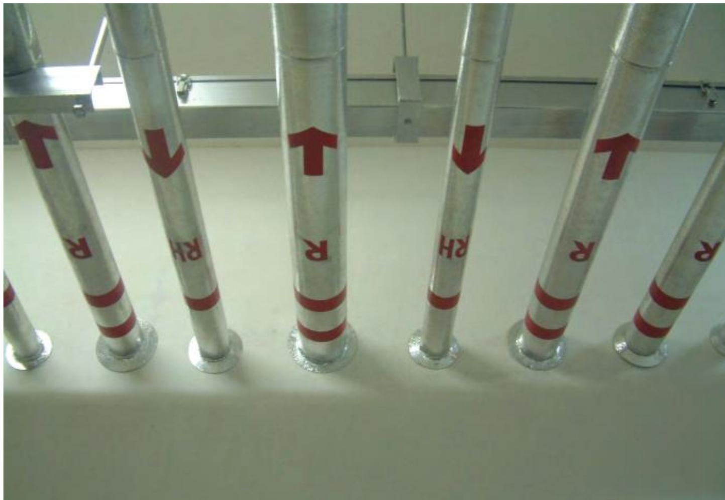
管道保温光滑平整，标识清晰，指示明确，管根处理美观
