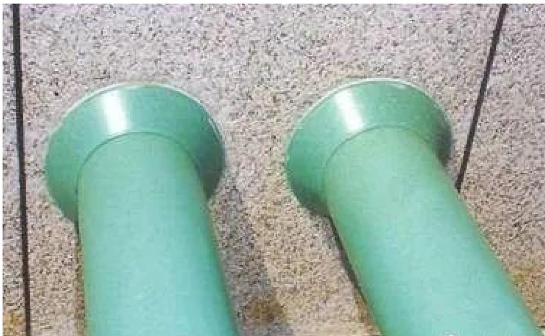
保温管道穿越墙面做收口装饰处理，装饰圈条用保护壳材质，成型美观
