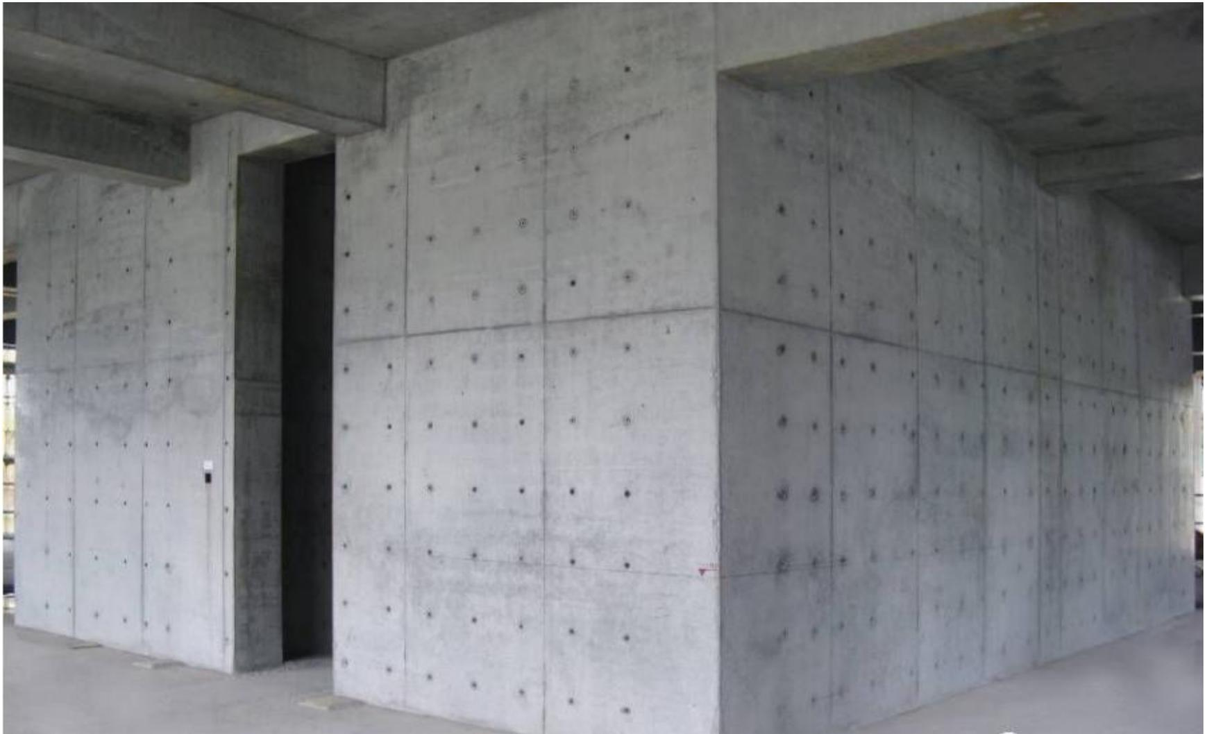
剪力墙混凝土结构内实外光、表面平整
