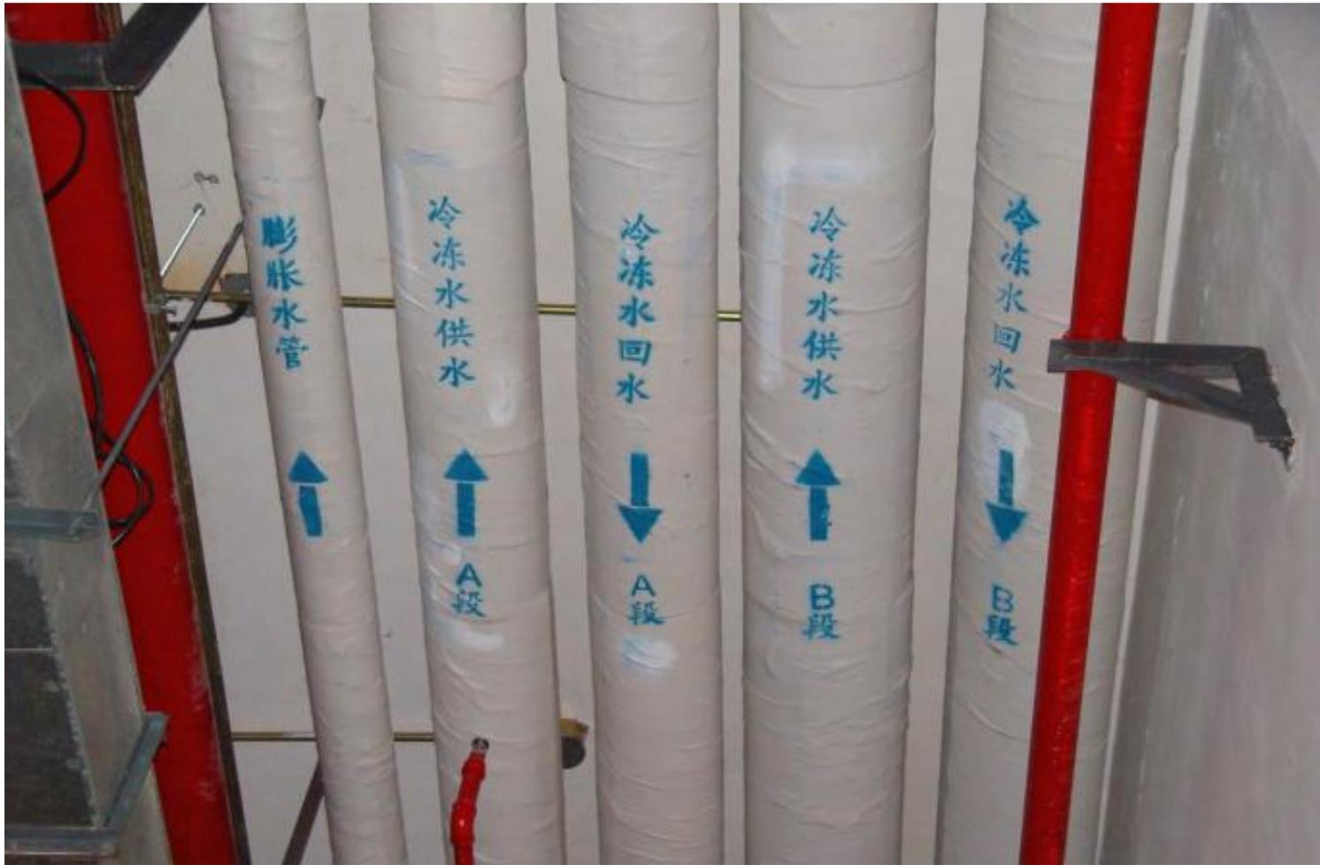
管道保温光滑平整，标识清晰，指示明确
