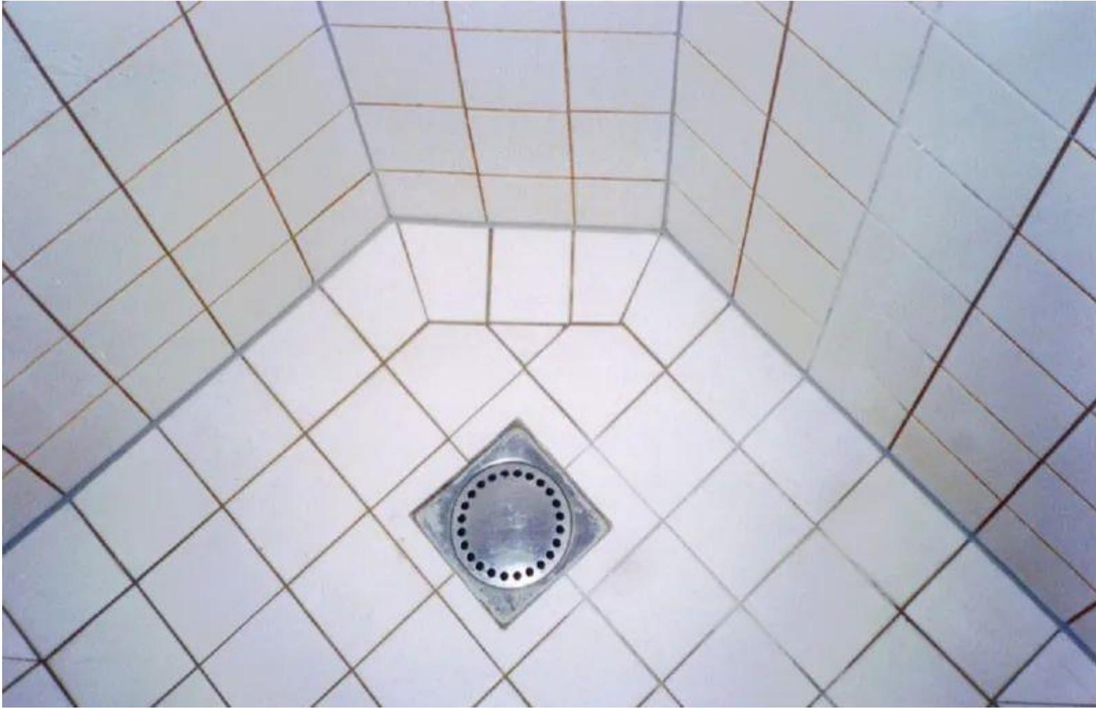
淋浴间墙面砖与地面砖（135度）对缝合理，阴角打胶封闭，地漏居中
