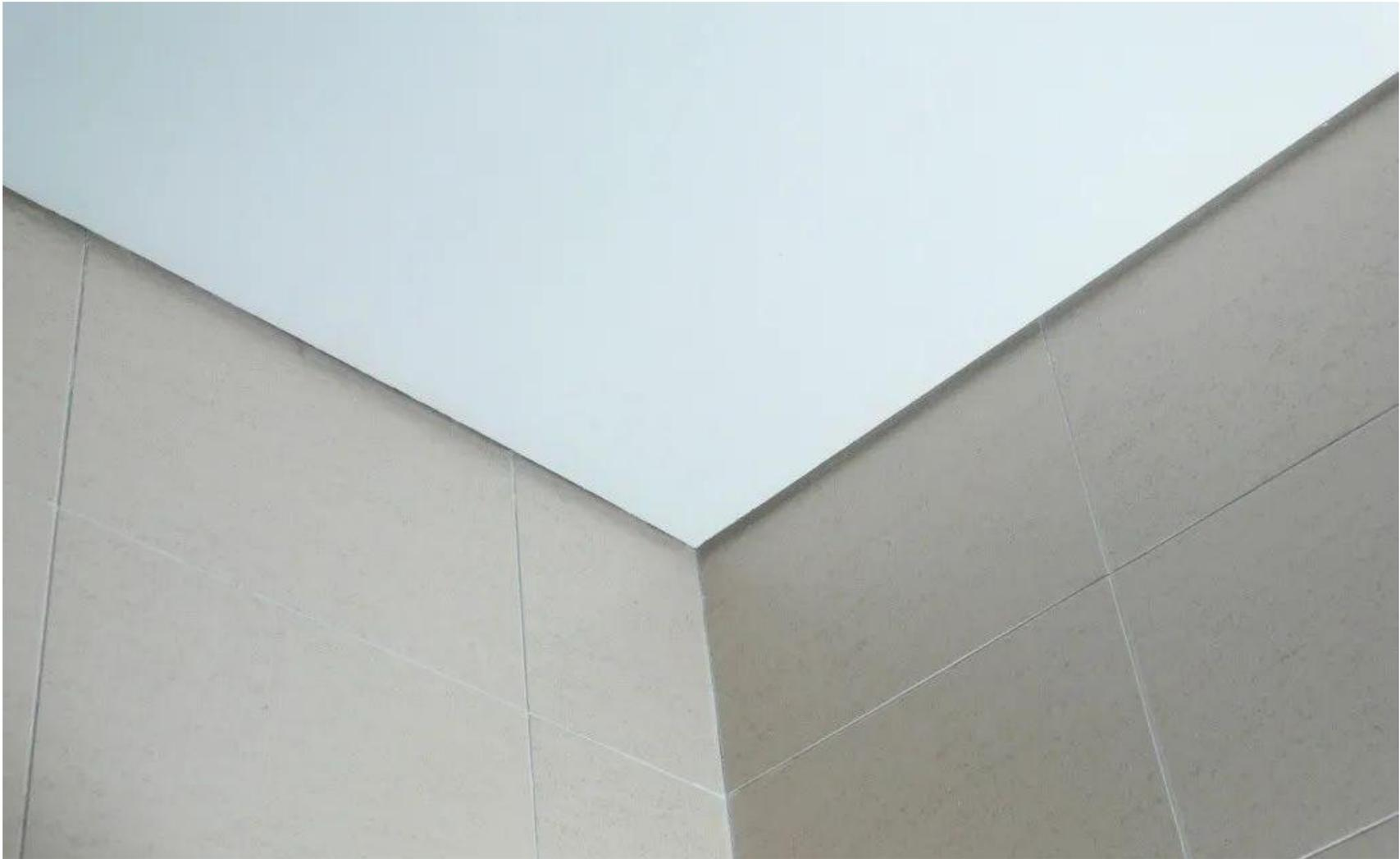
纸面石膏板吊顶与墙面交接部位留置凹槽等措施，表面平整无开裂
