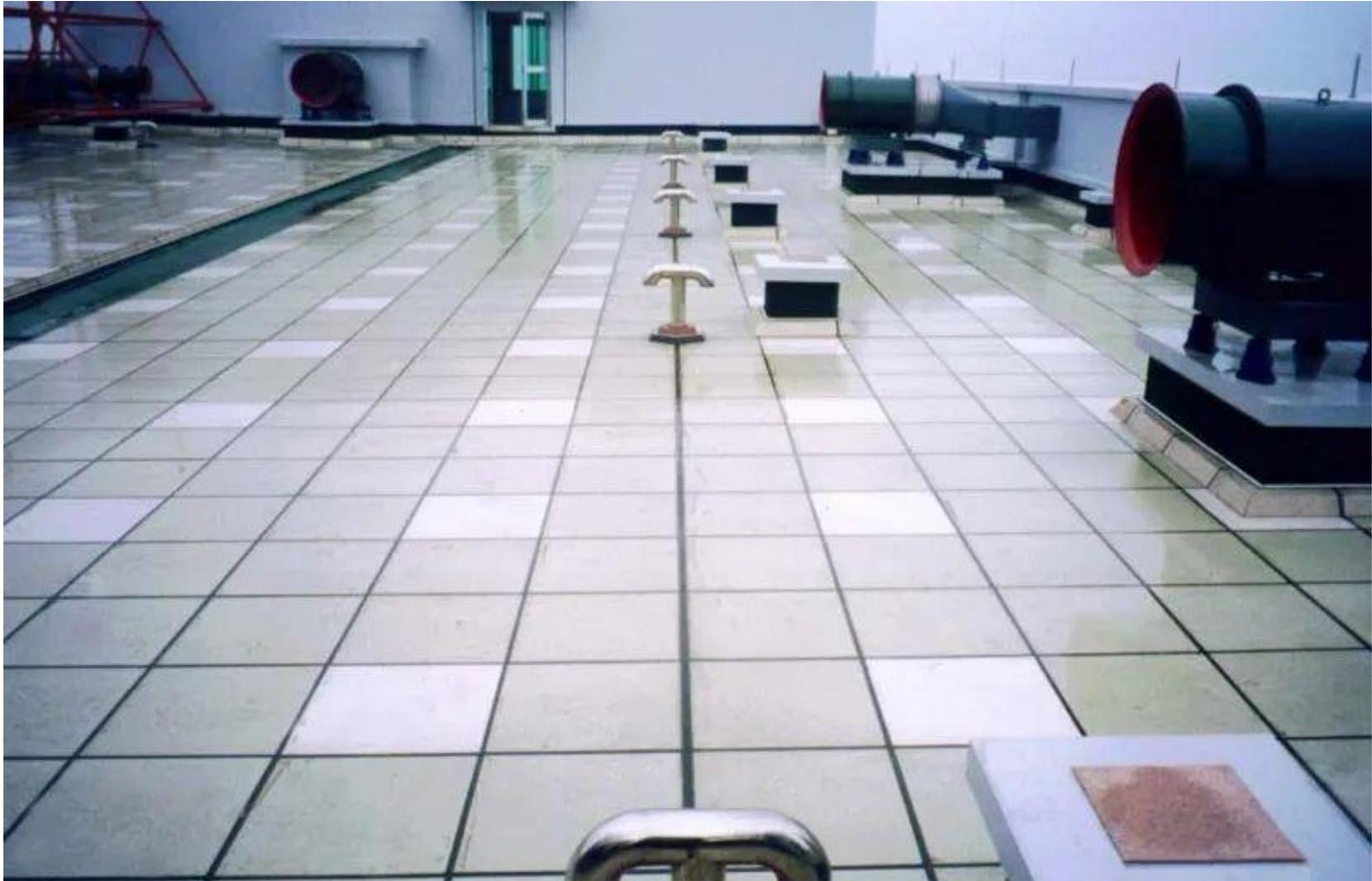
屋面不锈钢排气管布置成排成线
