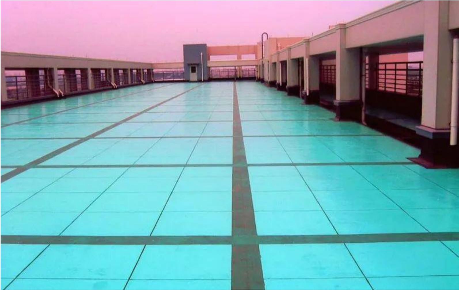
上人屋面表面平整、坡度符合要求，分缝合理
