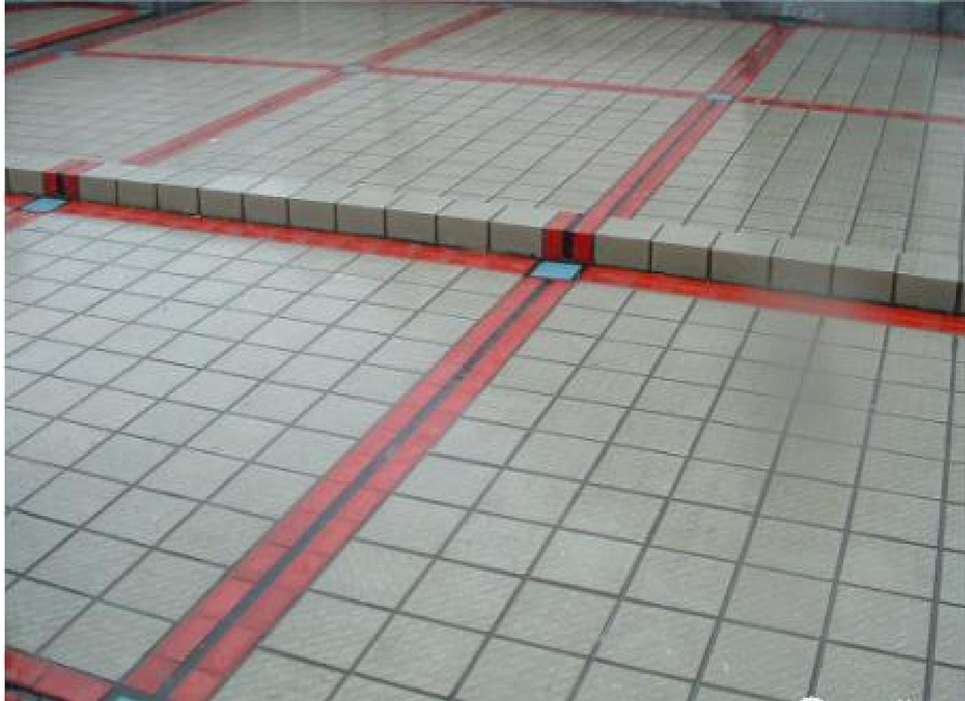
屋面分色与分格整齐，面砖平整，分格缝油膏嵌填密实顺直
