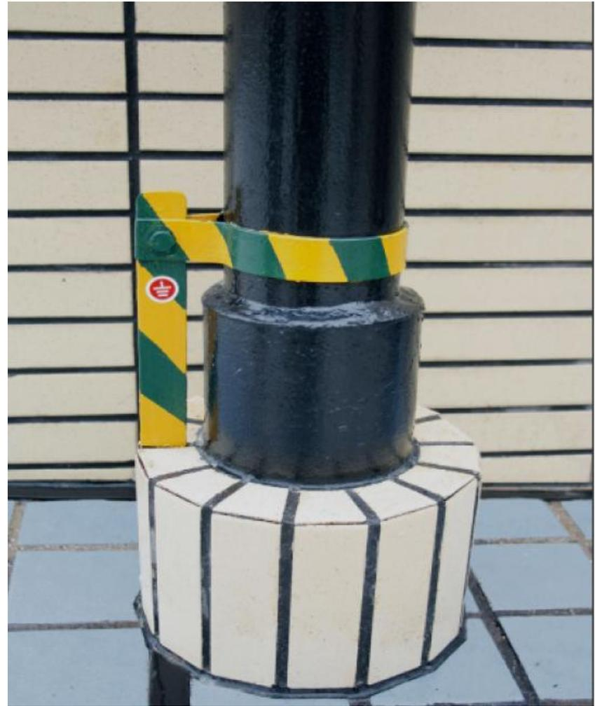
通气管标识及管根收口防雷接地
